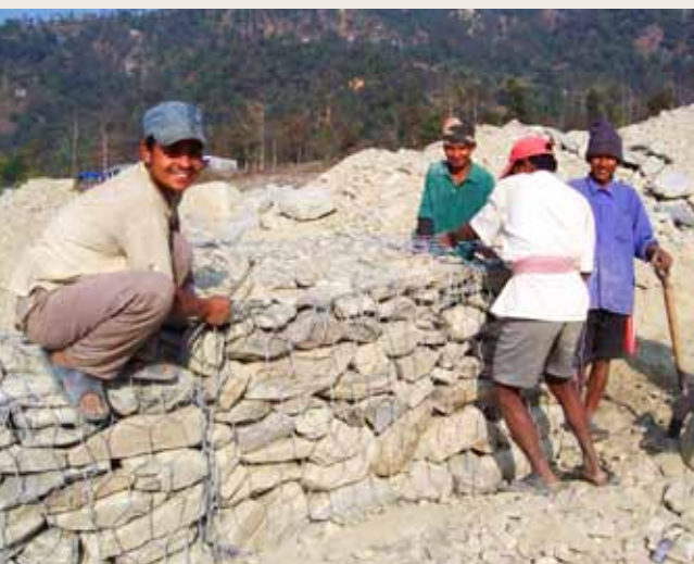
Bau von Schutzwällen mit Hilfe von Gabionen 2008
