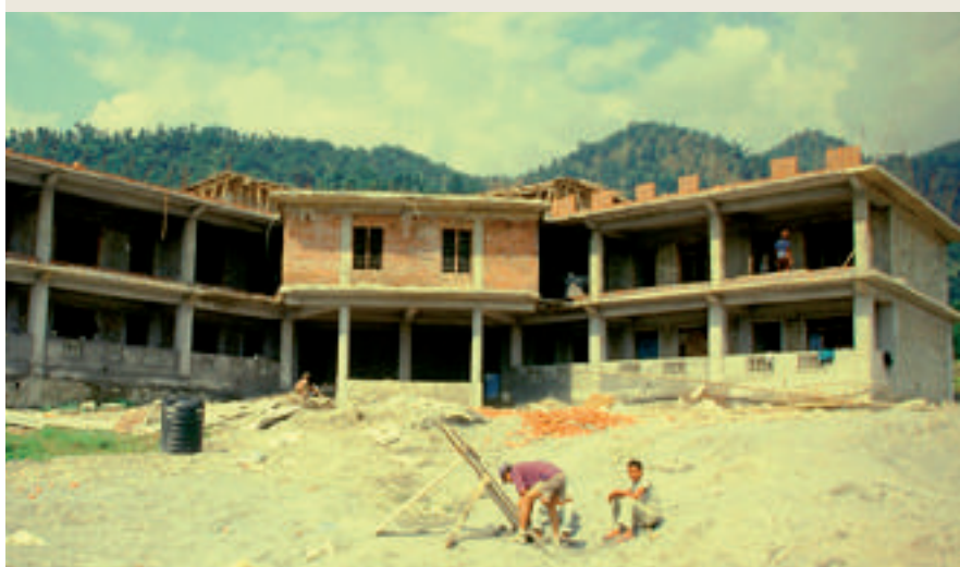
oben: Haus A des Kinderdorfes im Jahre 2000 kurz vor der Fertigstellung unten: Bau der Shree Shanta Secondary School 2001
