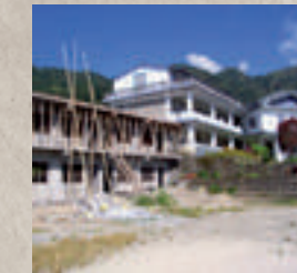
Bau der Grundschule der Shree Shanta Secondary School
