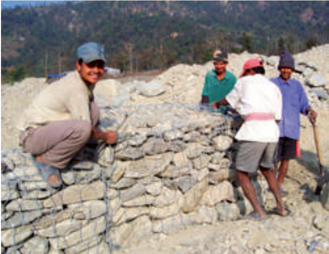
Bau von Schutzwällen mit Hilfe von Gabionen 2008
