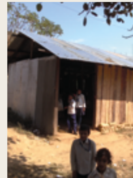
eingebaute Wellbleche
