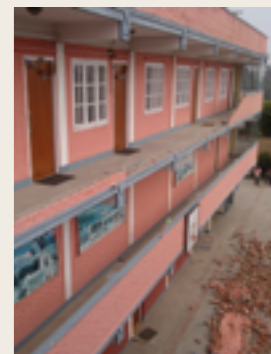
Schäden am Hostel
