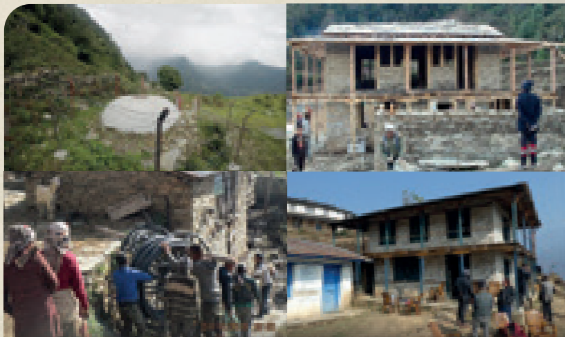
Ganz links: Wasserspeicher, Verlegung der Leitungen Links: Gebäude des Jugendclubs Unten: Schulgebäude
